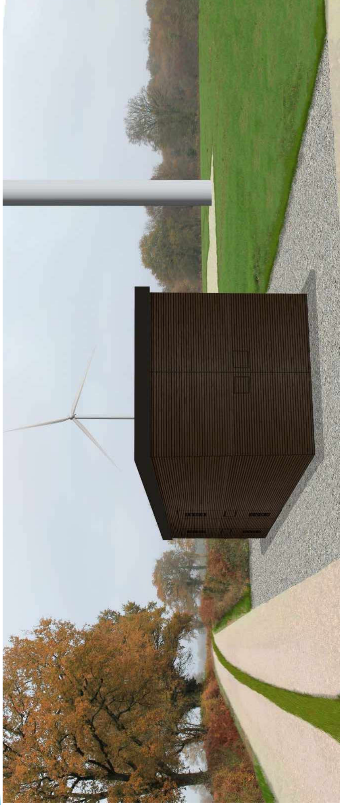
Vue F finale : vue proche, depuis le poste de livraison
