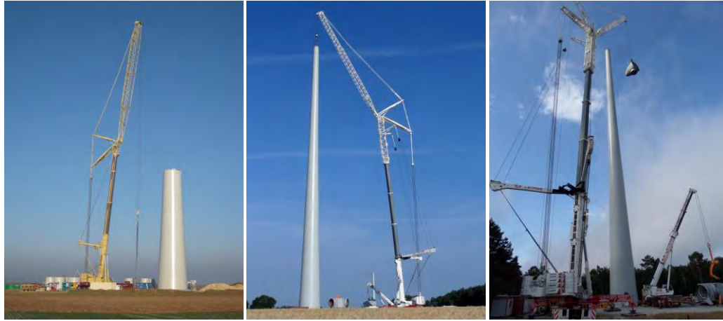
Assemblage du mât (Source : ENERCON)
