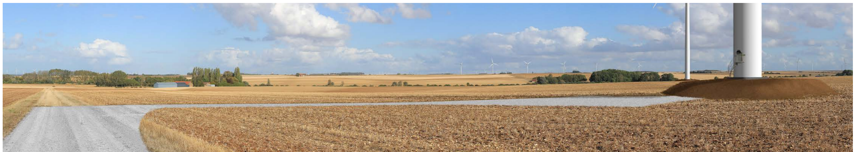
Figure 118 : Simulation d'intégration du projet, vue depuis le nord-est au niveau du chemin agricole reliant la RD31 au hameau de Villepeuple (PHM2)
