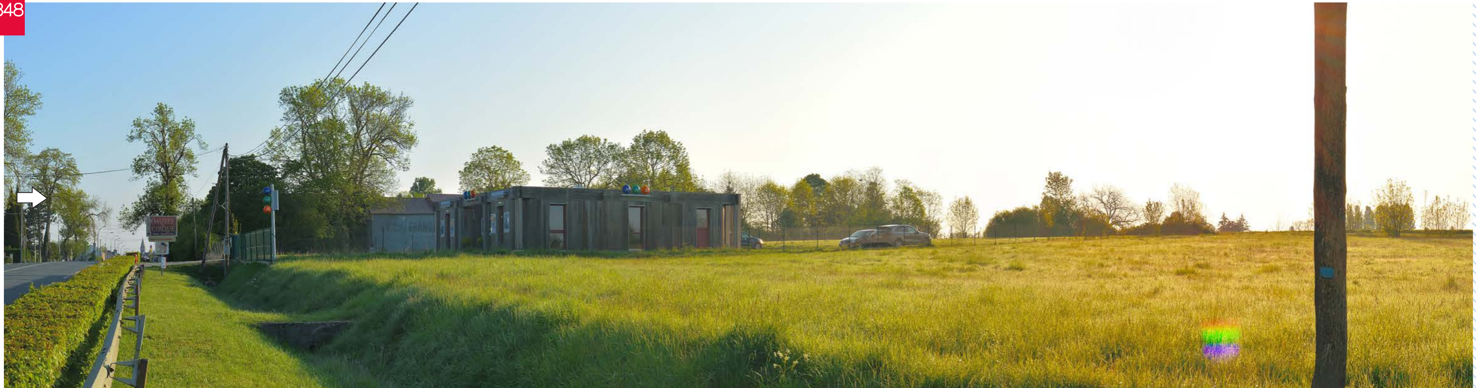
Photo 174 : Photomontage à 360° de l'insertion du projet du Champ des Vignes depuis la sortie sud du village de Vatan
