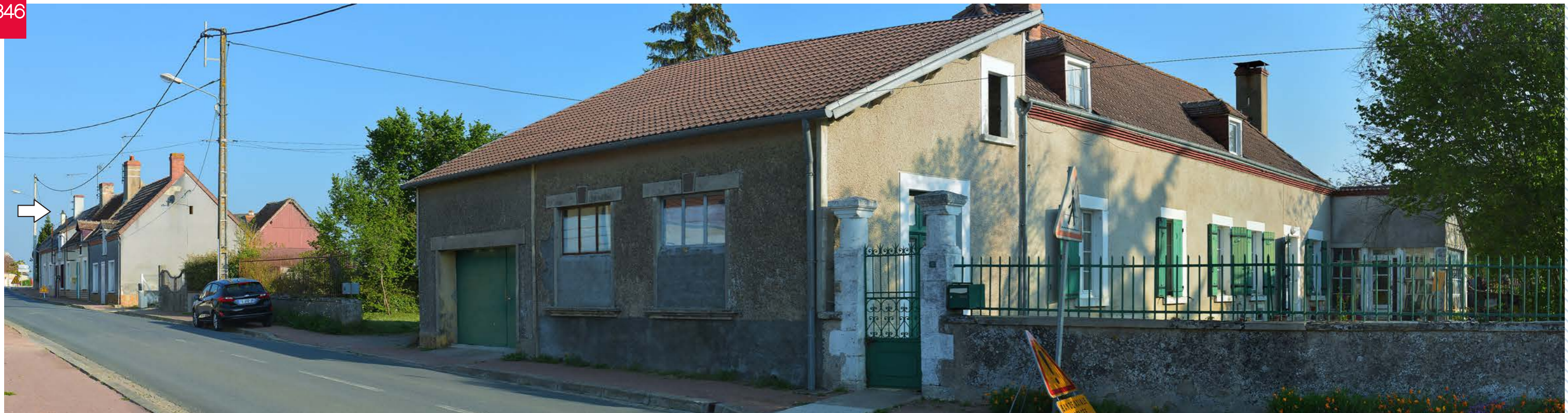
Photo 173 : Photomontage à 360° de l'insertion du projet du Champ des Vignes depuis la frange nord-ouest du village de Vatan
