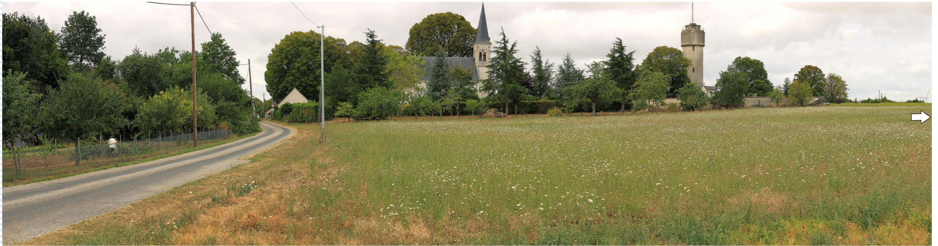
Parc éolien de Paudy
