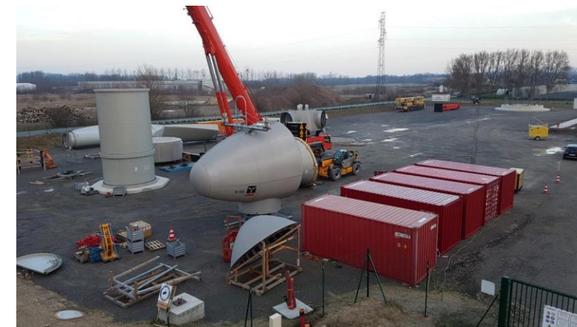
Centre formation international Enercon (Longueil-Sainte-Marie) (Source : ENERCON)
