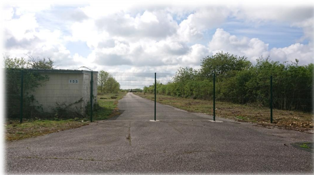
Figure 10 : Vue sur le futur accès des secours
