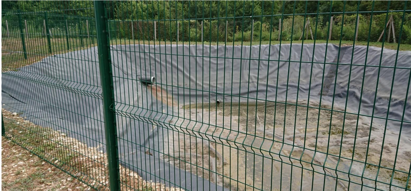
Figure 15 : Exemple de bassin étanche
