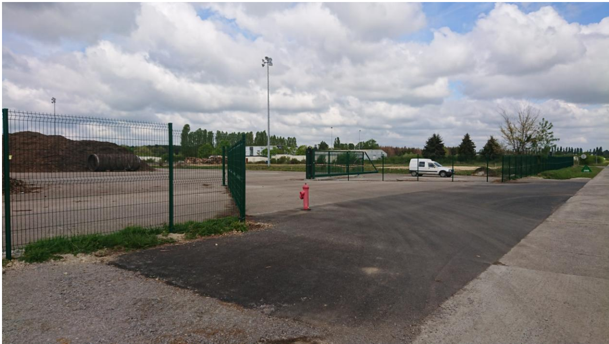
Figure 5 : Vue sur l'entrée du site.
