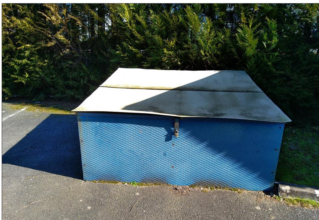
Figure 5 : Illustration photographique du forage, observé le 27/02/23
