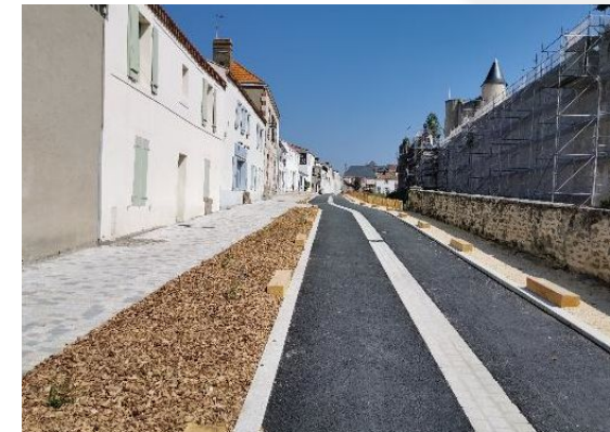
Sécurité Barrières, potelets, bastaings...
