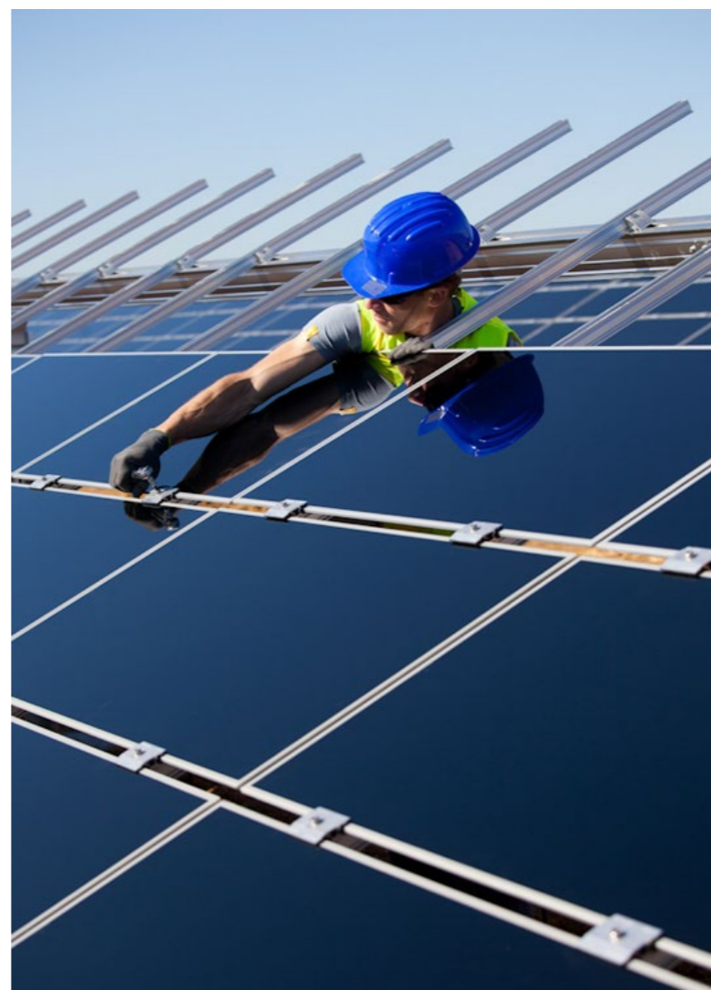
Remplacement de module (crédit photo EDF Renouvelables)
