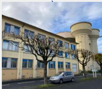
Château d'eau de la Ville
