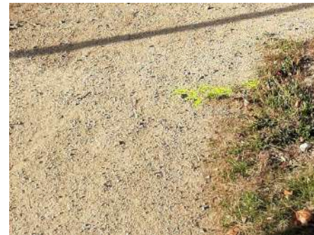
Mélange terre/pierre ou stabilisé
