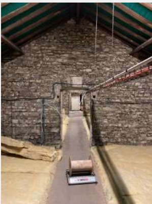
Combles bâtiment C
