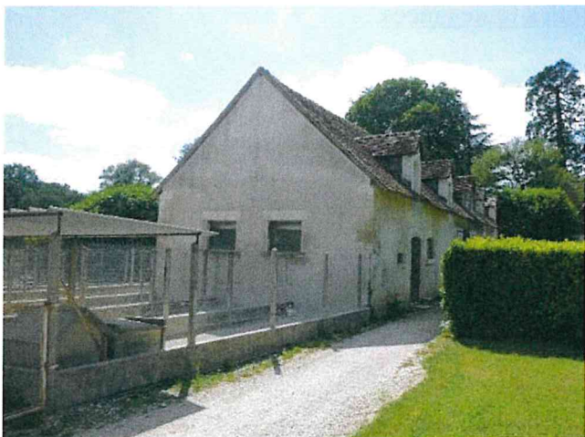
Photo 7 : aspect extérieur du bâtiment du côté du pignon Est (partie élevage)
