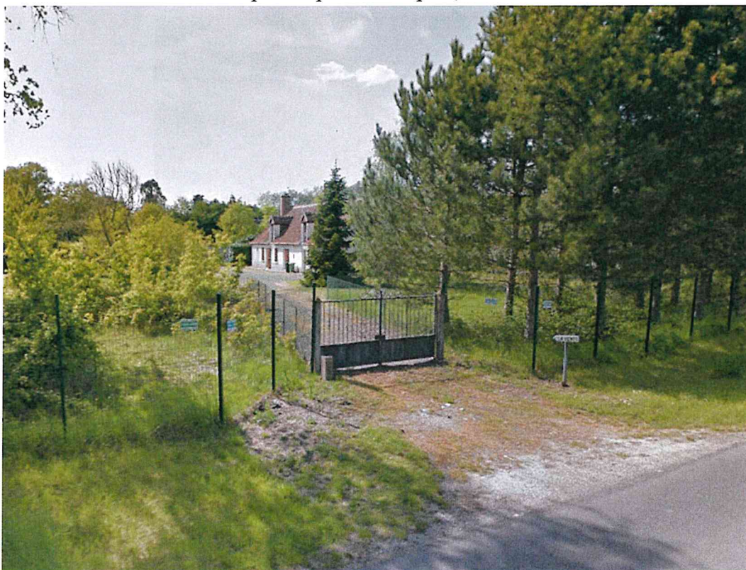
Photo 20 : Vue du portail principal (n° 1) avec le bâtiment d'accueil à l'arrière-plan
