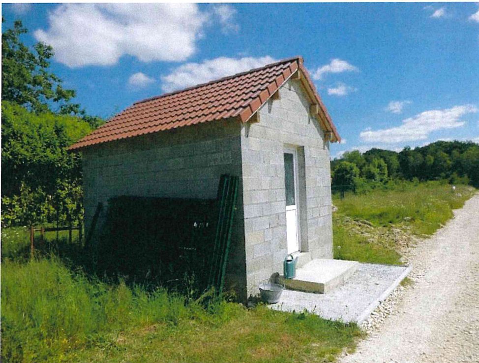
Photo 10 : aspect des petits bâtiments de stockage des croquettes – Locaux techniques
