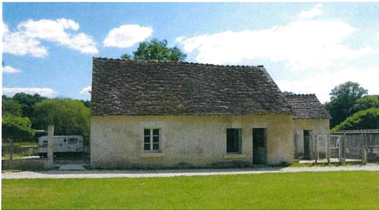
Photo 5 : aspect extérieur du bâtiment, groupe électrogène sur la gauche du bâtiment
