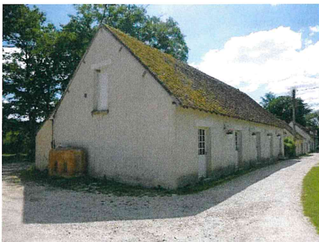
Photo 3 : aspect extérieur du bâtiment
