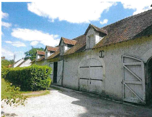
Photo 8 : aspect du bâtiment côté ouest (stockage)
