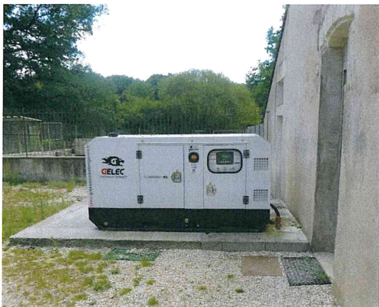
Photo 34 : Groupe électrogène
