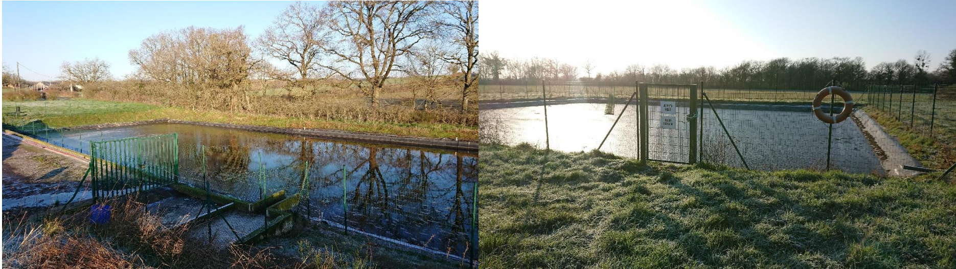
Figure 13 : Vue sur les bassins étanches nord (à gauche) et sud (à droite)
