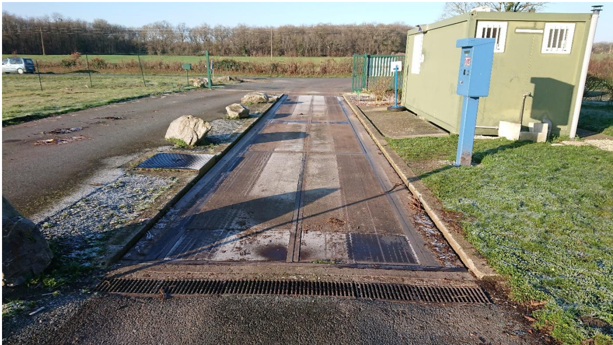
Figure 18 : Vue sur le pont à bascule
