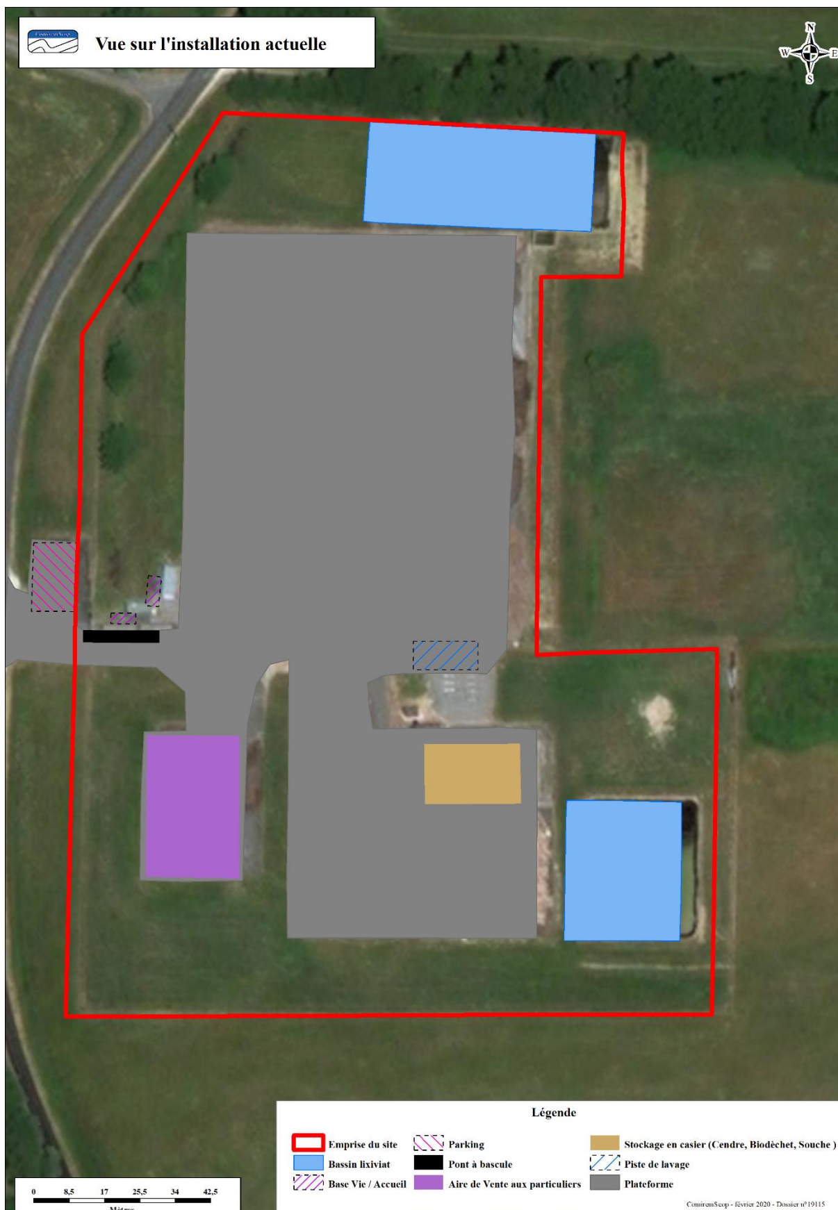
Figure 5 : Vue aérienne sur le site
