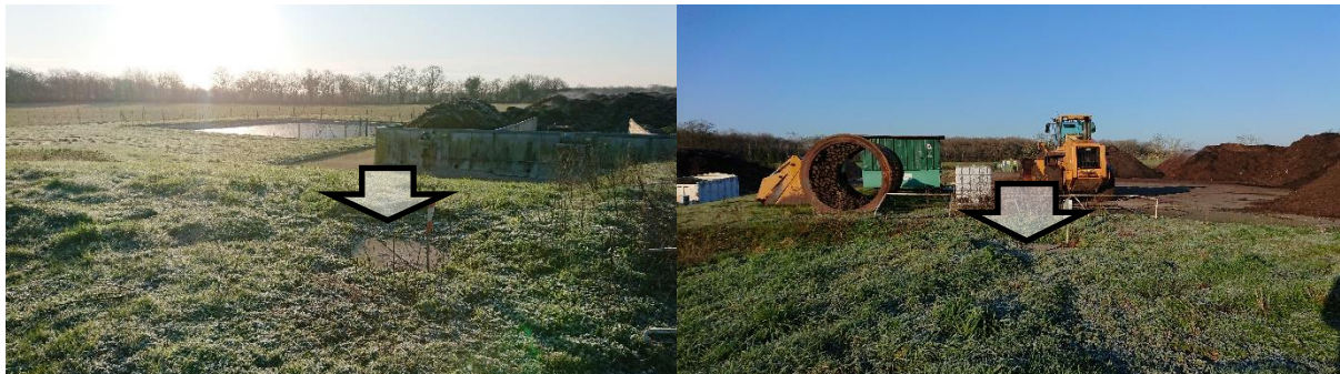
Figure 15 : Séparateur à hydrocarbures en aval de la zone de stockage du chargeur
