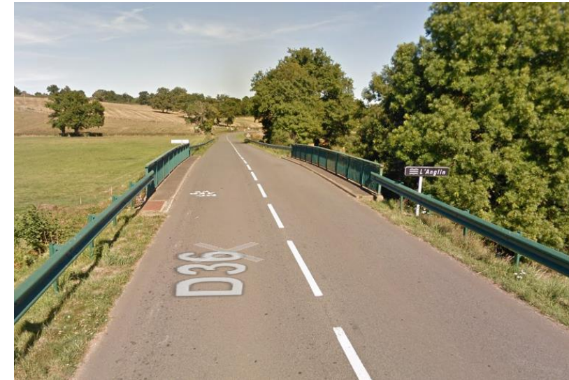
Figure 22 : Franchissement de la rivière L'Anglin par la RD36
