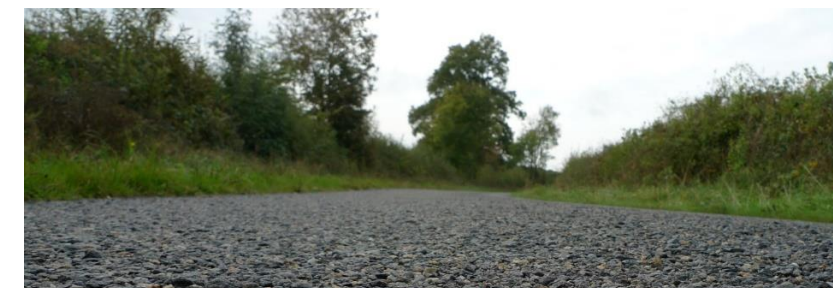
Figure 28 : Vue de la RD et de ses accotements
