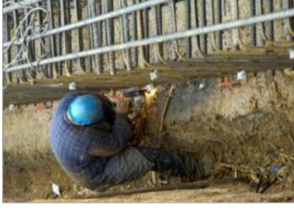
Figure 114 : Préparation des fondations
