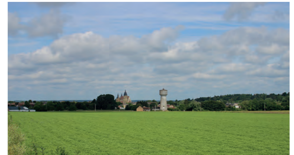
Photographie 17 : Les châteaux d'eau eux aussi sont des éléments repérables
