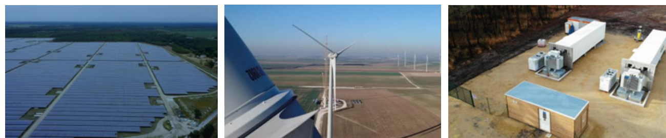
De gauche à droite, Centrale Solaire de Cestas (300 MWc), Centrale Eolienne de Bussy-Létrée (26 MW), et Azur Stockage (6 MW, 6MWh) (source : NEOEN, 2019)
