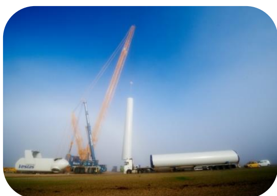
Livraison et Montage des tronçons de mâts
