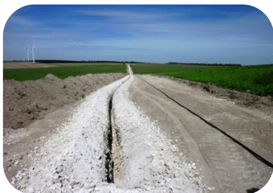
Réalisation des pistes et du câblage
