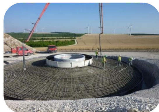
Coulage de la fondation
