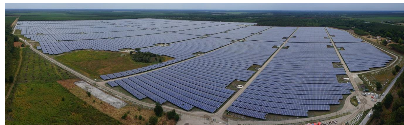
Chantier de la centrale photovoltaïque de Cestas (300 MW) (source : NEOEN, 2018)
