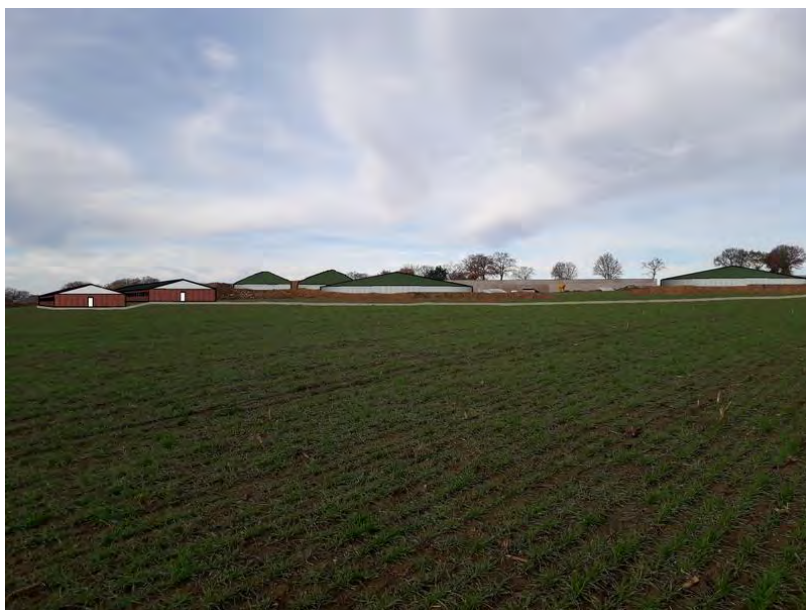
Vue depuis l'est du site
