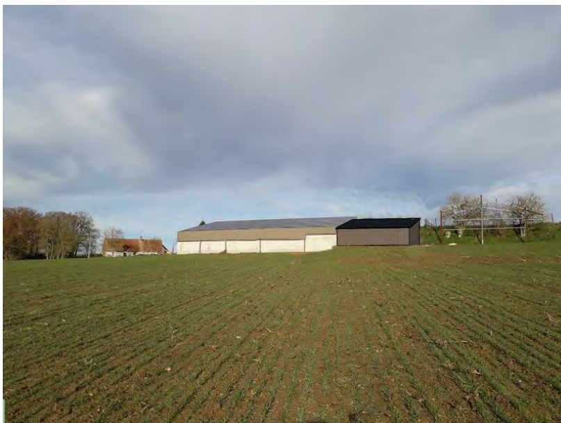
Vue depuis le sud du site
