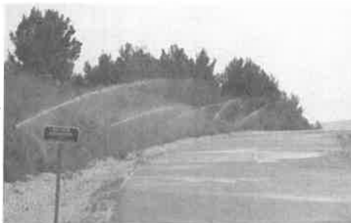
Aspersion des pistes par arroseur fixe Photo n° 31
