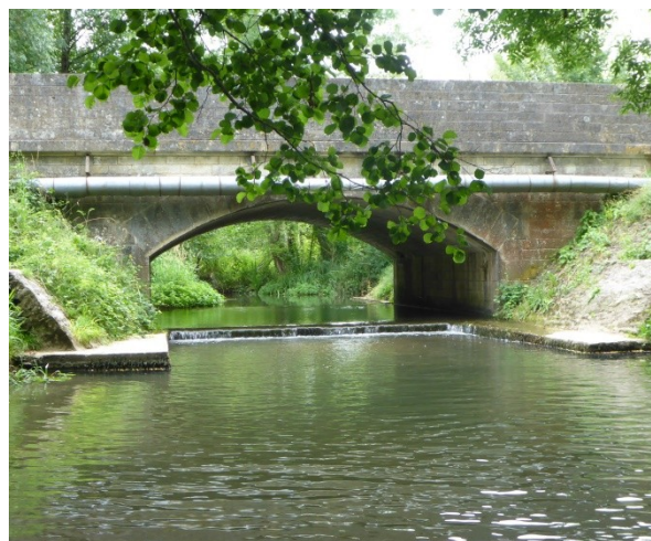
Figure 69 : Radier sous pont sur la Claise (pont de la D11 à Vendœuvres)
