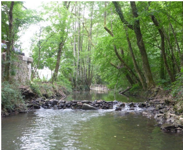
Figure 70 : Seuil en enrochement artisanal sur de la Claise (300 m en aval du pont de la D11 à Vendœuvres)
